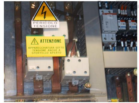
Abb. 5: Stromwandler der Verbundanlage
